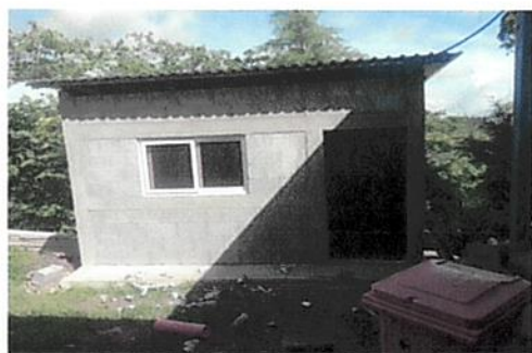
Foto 3: Sustitución de puerta de cocina
