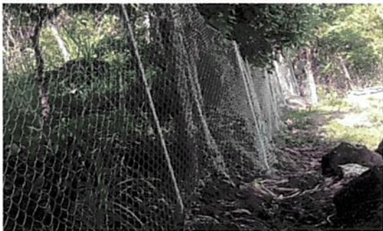
Foto 5: Cambio de Malla muro perimetral
