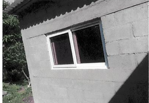
Foto 2: Mejoramiento de ventanas de PVC
