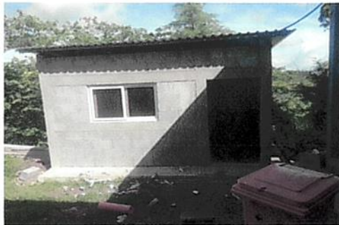
Foto 3: Sustitución de puerta de cocina
