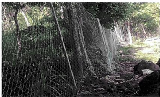
Foto 5: Cambio de Malla muro perimetral
