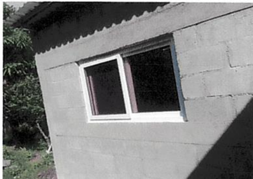
Foto 2: Mejoramiento de ventanas de PVC
