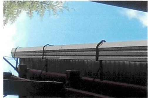
Foto 4: Sustitución de canales y bajadas de agua
