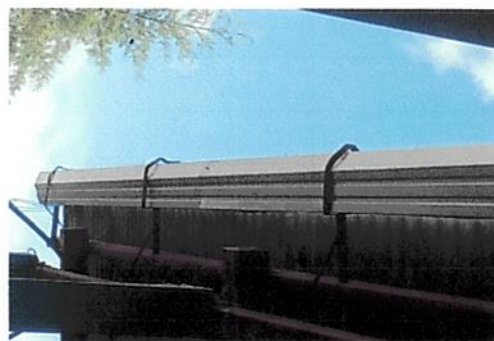
Foto 4: Sustitución de canales y bajadas de agua
